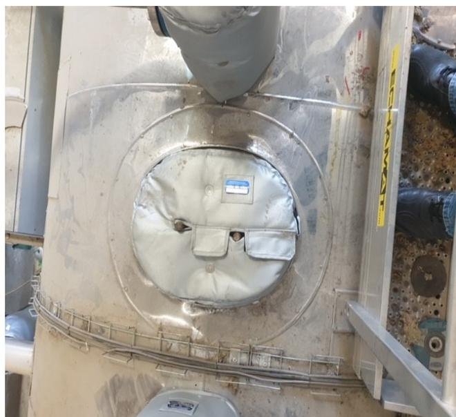
Les couvertures thermiques Neovee sont des éléments d'isolation **souples** et **démontables**, fabriqués sur-mesure pour s'adapter au mieux à votre installation. Ils protègent vos opérateurs et permettent d'éviter les pertes énergétiques des différents organes de vos réseaux vapeur.
